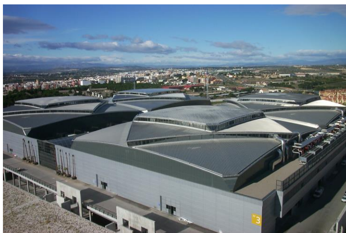
Pabellones 1 y 2 terminados
