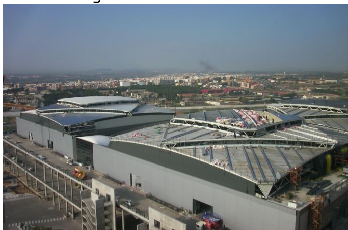
Construcción de los pabellones 1 y 2
